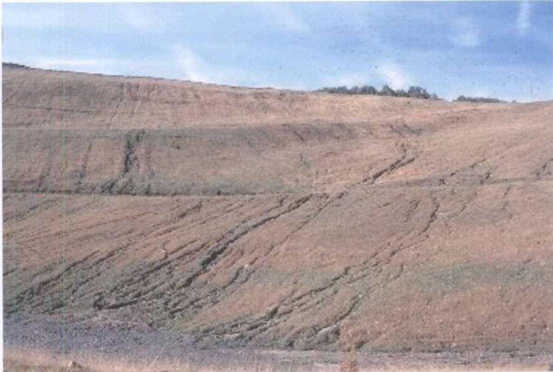
**Fotografía A.III.3.** Aspecto que ofrecen los taludes orientados sensiblemente al norte en la Zona de Carrasconte. Se puede observar la incidencia de la erosión en regueros (septiembre, 2001).
