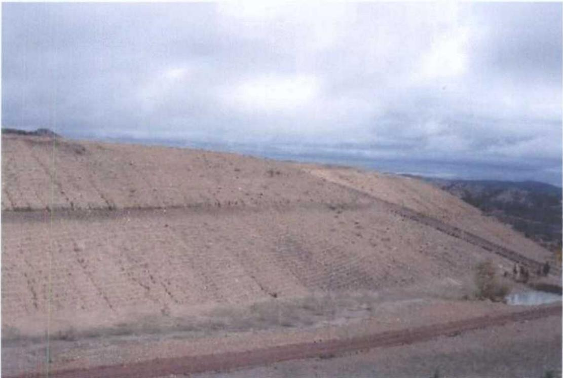
**Fotografía A.III.24.** Panorámica de taludes en solana en la Zona de Sabina-Umbrión (MFUSA) (marzo, 2002). Pueden observarse, tanto las huellas que dejó el subsolado, como los regueros y cárcavas que se forman a pesar de que se diera dicha labor siguiendo curvas de nivel.
